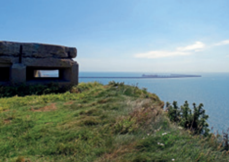
Bunker, La Poterie-Cap-d'Antifer
