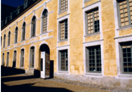
Cité des abbesses, Montivilliers
