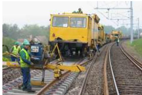
Longs Rails soudés sur traverses béton
