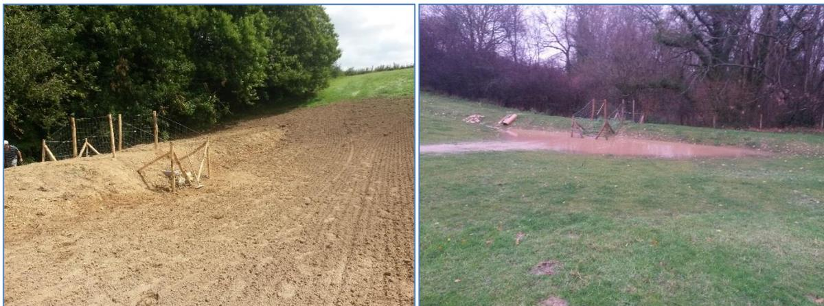
Figure 27 : Merlon busé après travaux / en fonctionnement (source SMBV)
