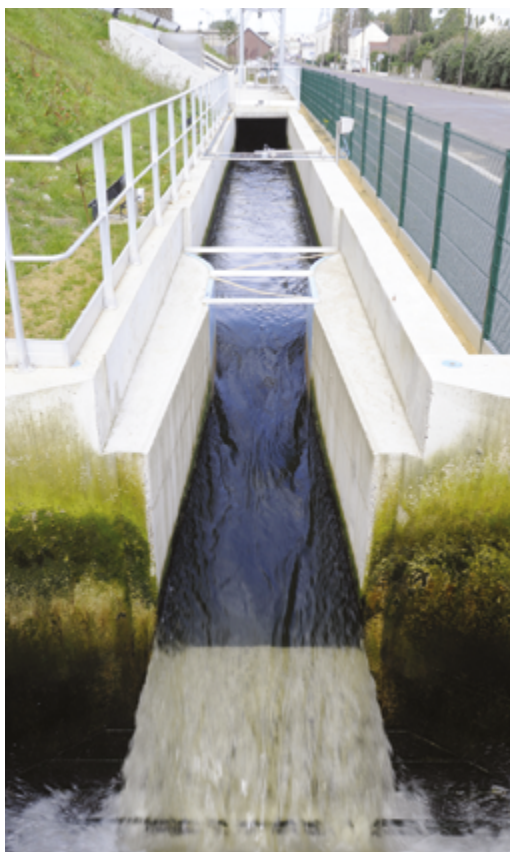
Usine de dépollution Edelweiss
