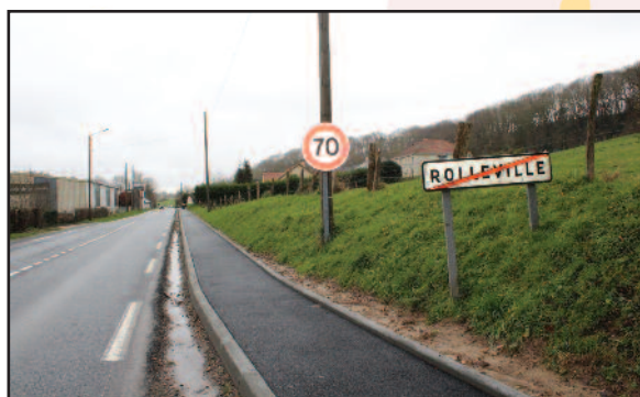
Cheminement piéton sur le CD32 (financé par la Communauté Urbaine)
