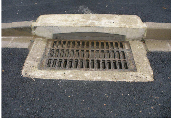
Photo d'une BE avec une bordure évidée et une grille de type 2 CODAH
