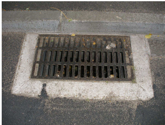
Photo d'une BE avec une grille de type 3 CODAH
