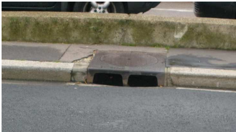
Photo d'une BE avec une grille de type 1 CODAH
