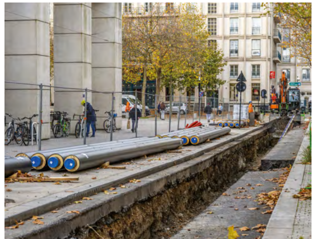
Les travaux d'extension du réseau de chaleur au Havre
