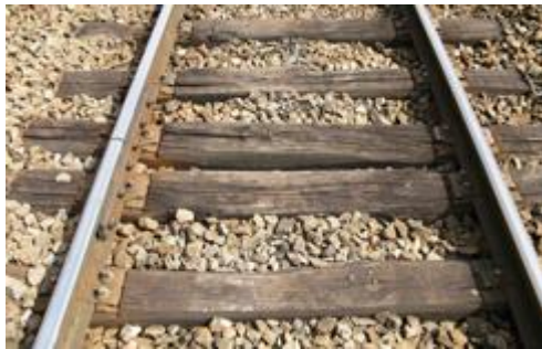
Rails courts sur traverses bois
