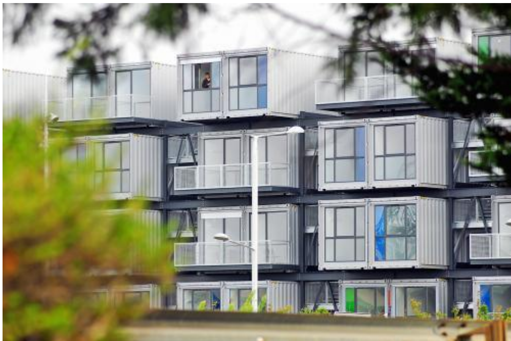
Cité A'Docks, logements étudiants en conteneurs au Havre ©LAURENT BRÉARD
