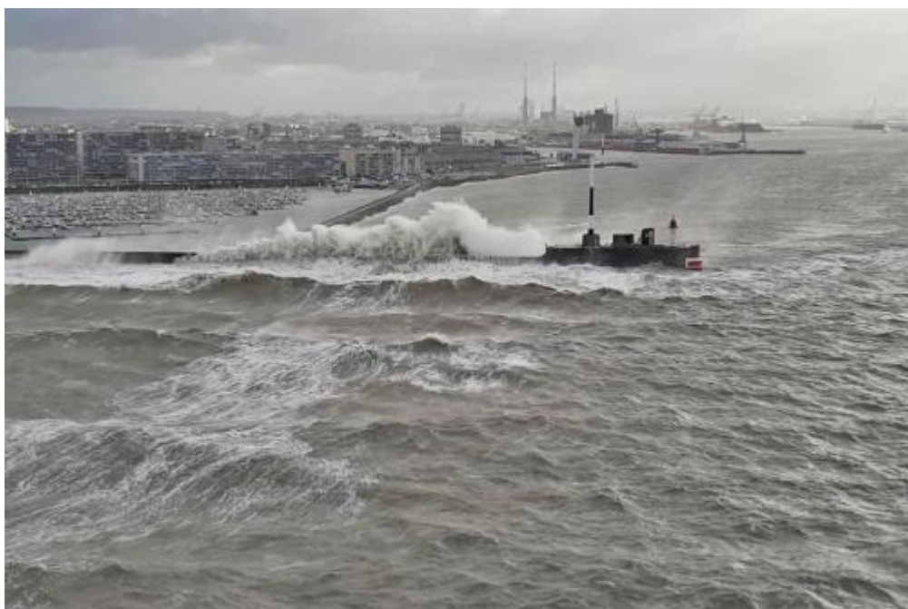
Tempête et submersion et la digue Nord du Havre ©LE HAVRE SEINE MÉTROPOLE
