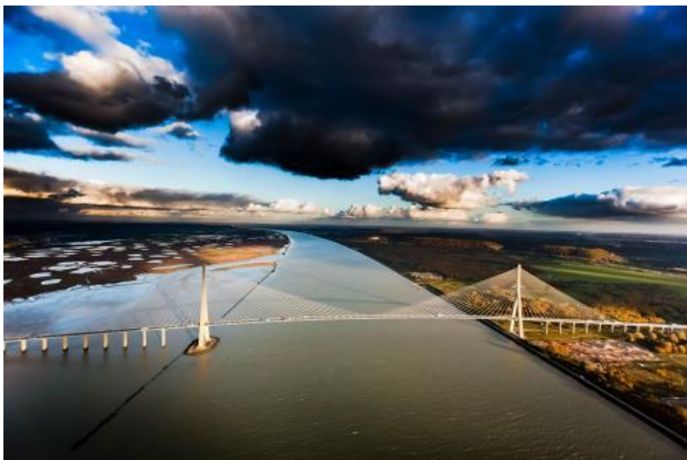
Pont de Normandie, estuaire de la Seine ©VINCENT RUSTUEL - ANGELS'SEA STUDIO
